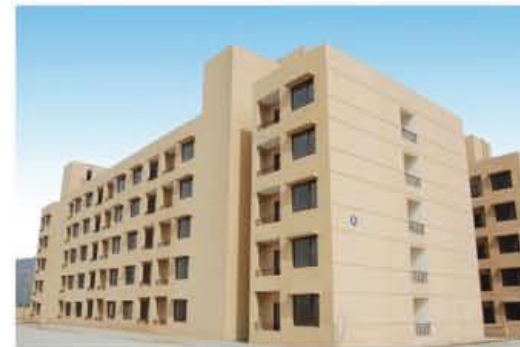
ANANT RAJ AASHRAY NEEMRANA, RAJASTHAN
