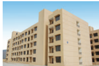
ANANT RAJ AASHRAY, NEEMRANA, RAJASTHAN
