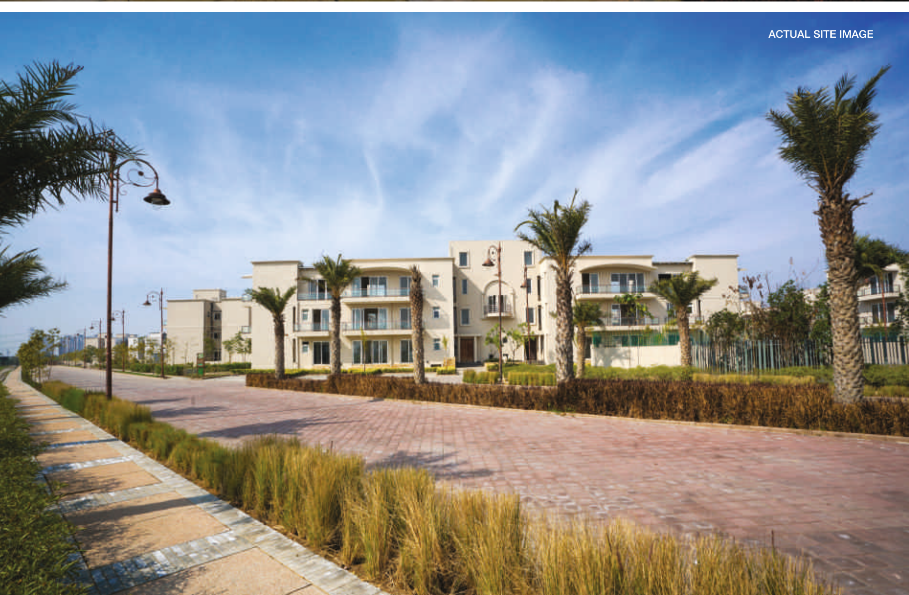
ACTUAL SITE IMAGE
