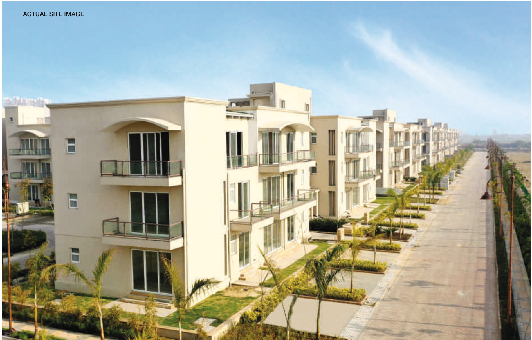
ACTUAL SITE IMAGE
