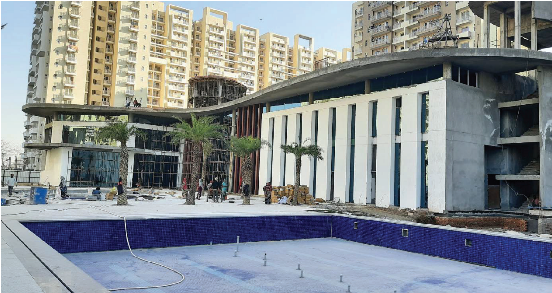
ACTUAL SITE IMAGE
