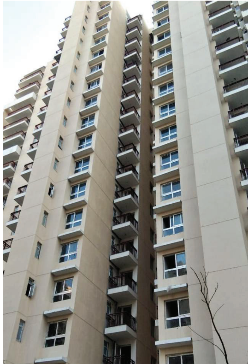
ACTUAL SITE IMAGE
