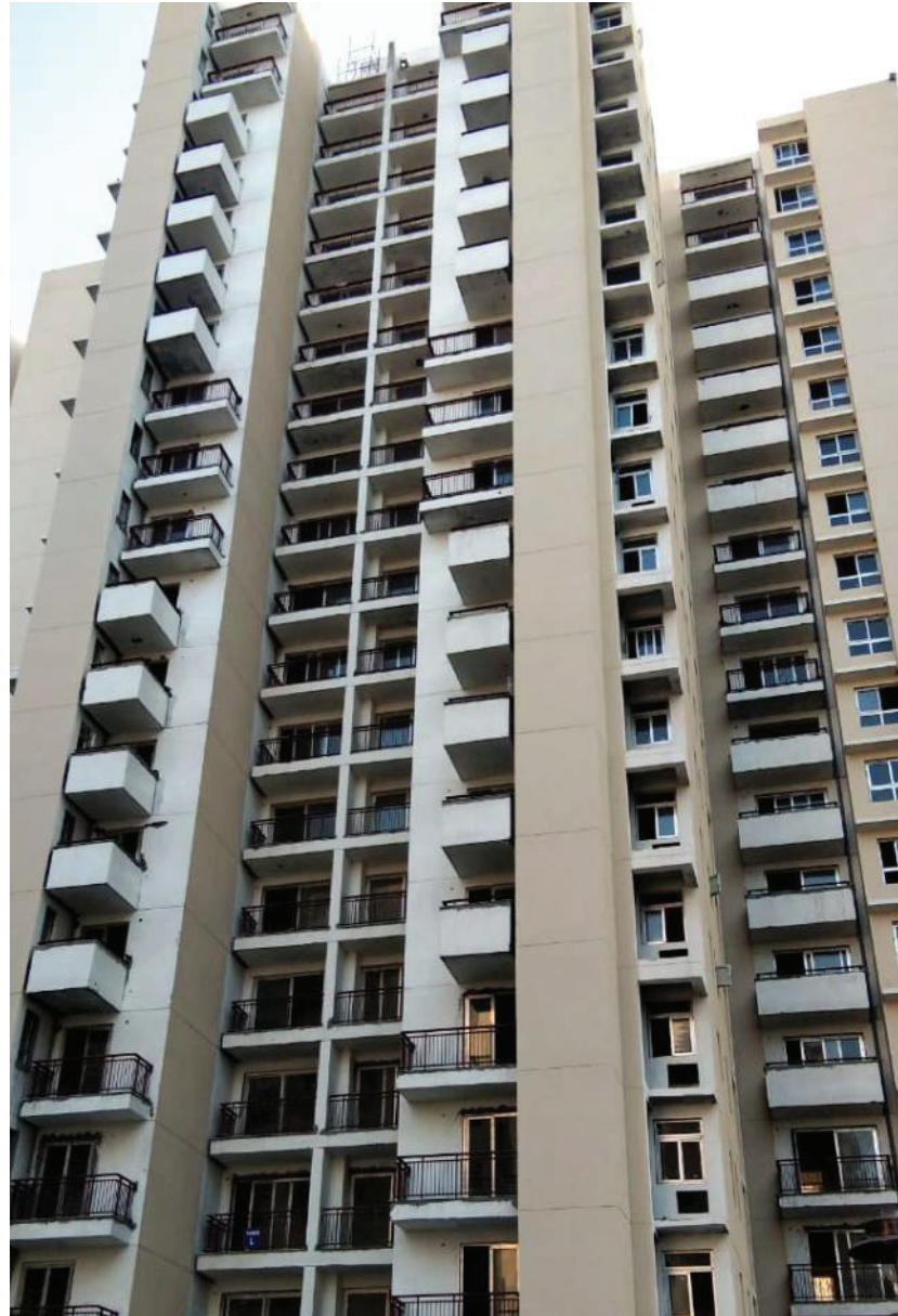
ACTUAL SITE IMAGE
