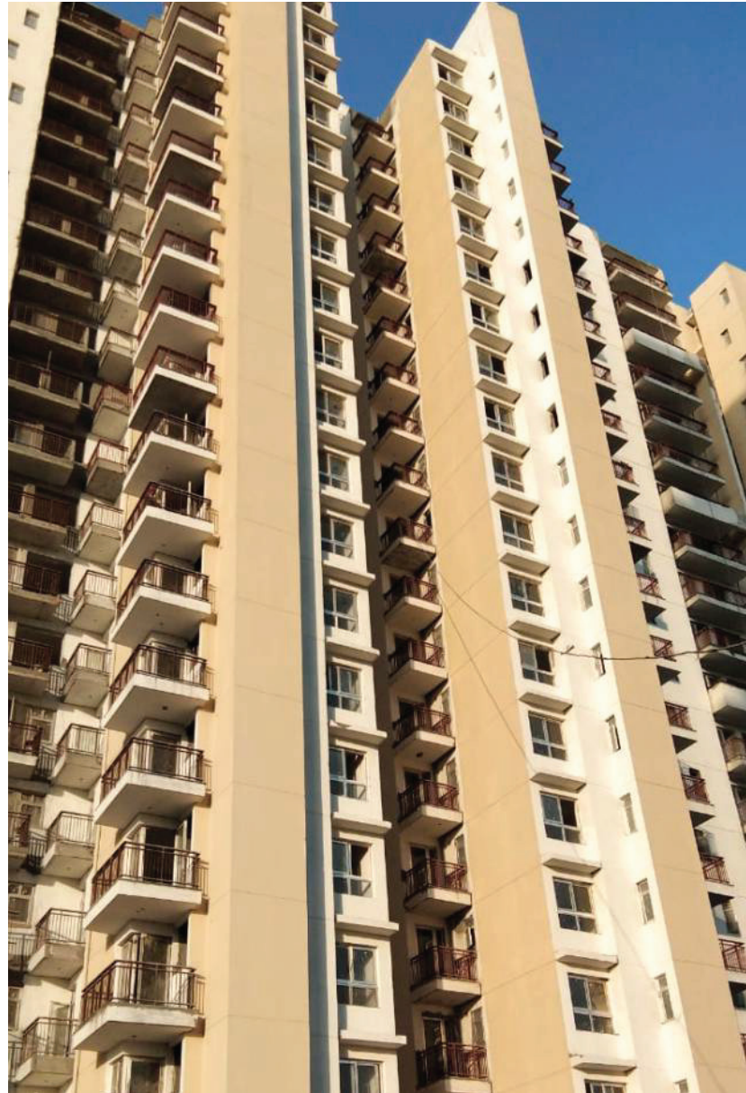
ACTUAL SITE IMAGE
